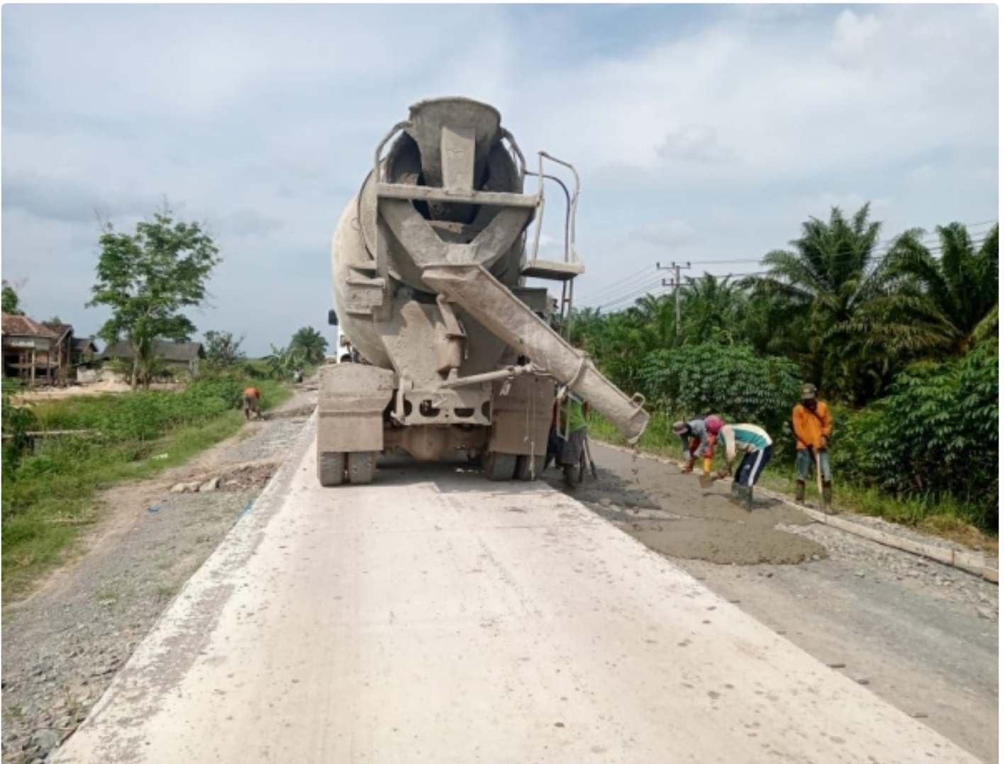
Bangun Jalan Rigid Beton KTM Wonosari
