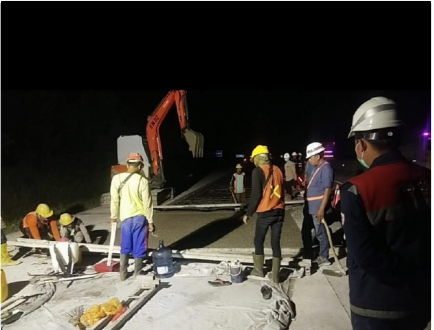
PT HKI Perbaikan Tol Terbanggi Kayu Agung
